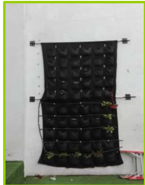
INSTALACIÓN MUROS VERDES
