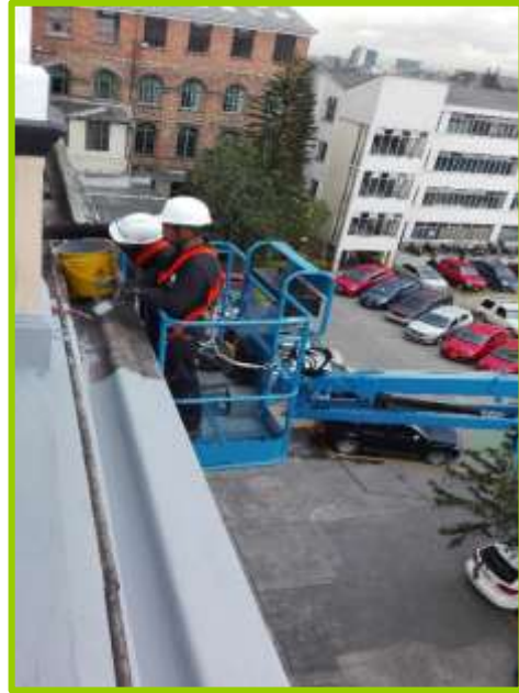
IMPERMEABILIZACION DE CANALES
