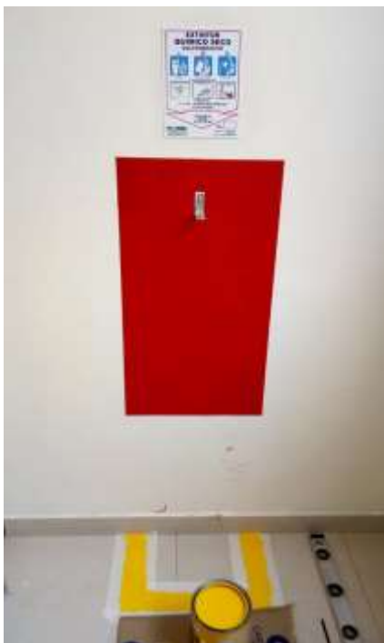
INSTALACIÓN Y DEMARCACIÓN EXTINTORES
