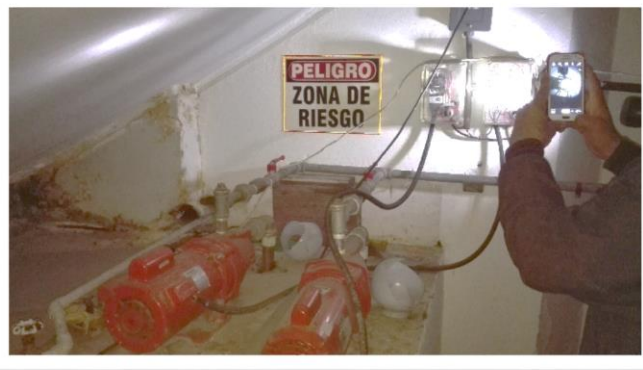
Inspección de la Red hidráulica, Revisión de sistemas de bombeo
