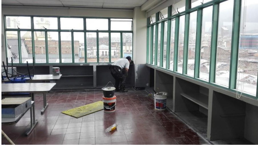
Mantenimiento pintura (muros y ventanas)
