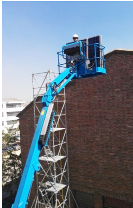
Imágenes equipos de Trabajo en Altura Fuente: Proyectos finales 2015
