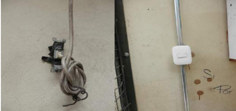
▼ Cambio de Iluminación y Montaje tubería para perrera de las ETITC
