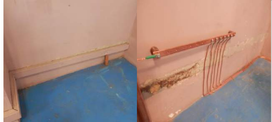
▼ Montaje de sistema Puesta tierra en el Laboratorio de prototipado
