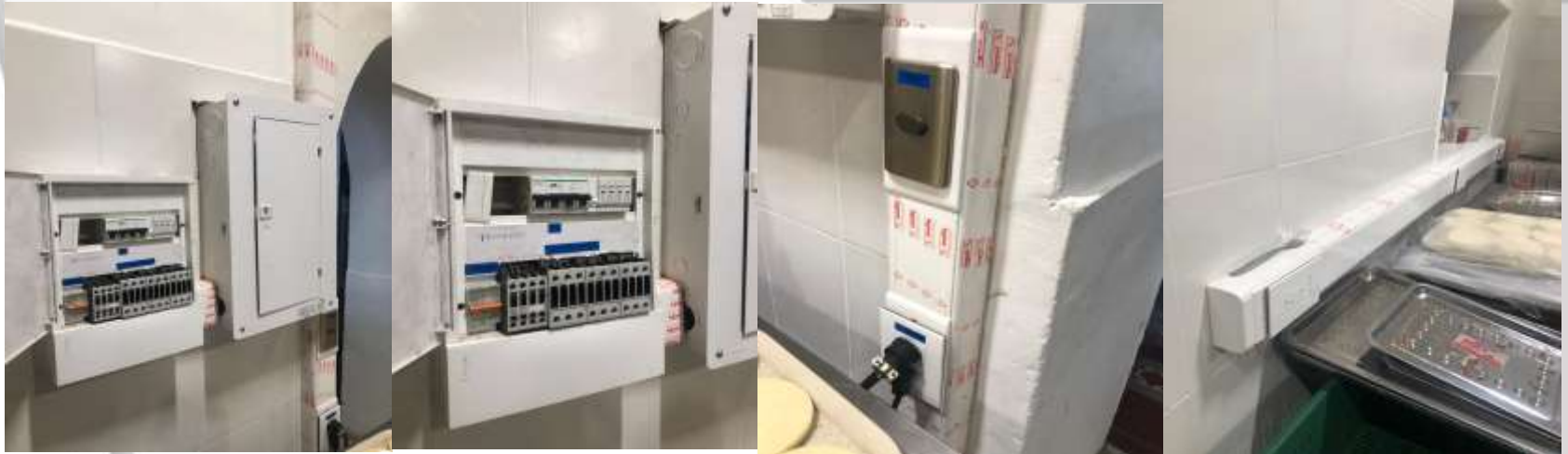
▼ Adecuaciones eléctricas en el banco de alimentos de la ETITC.
