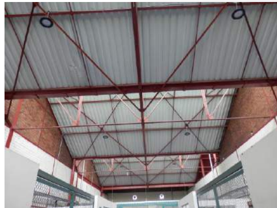
Iluminación taller motores
